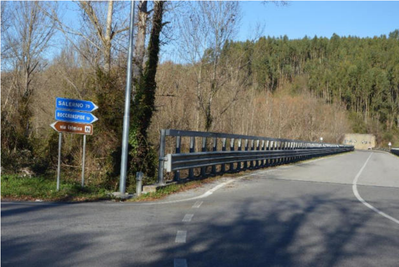
Indicazione della via Istmica presso il ponte delle "Sette Luci" sul Torrente Fasanella zona A1 PNCVDA
